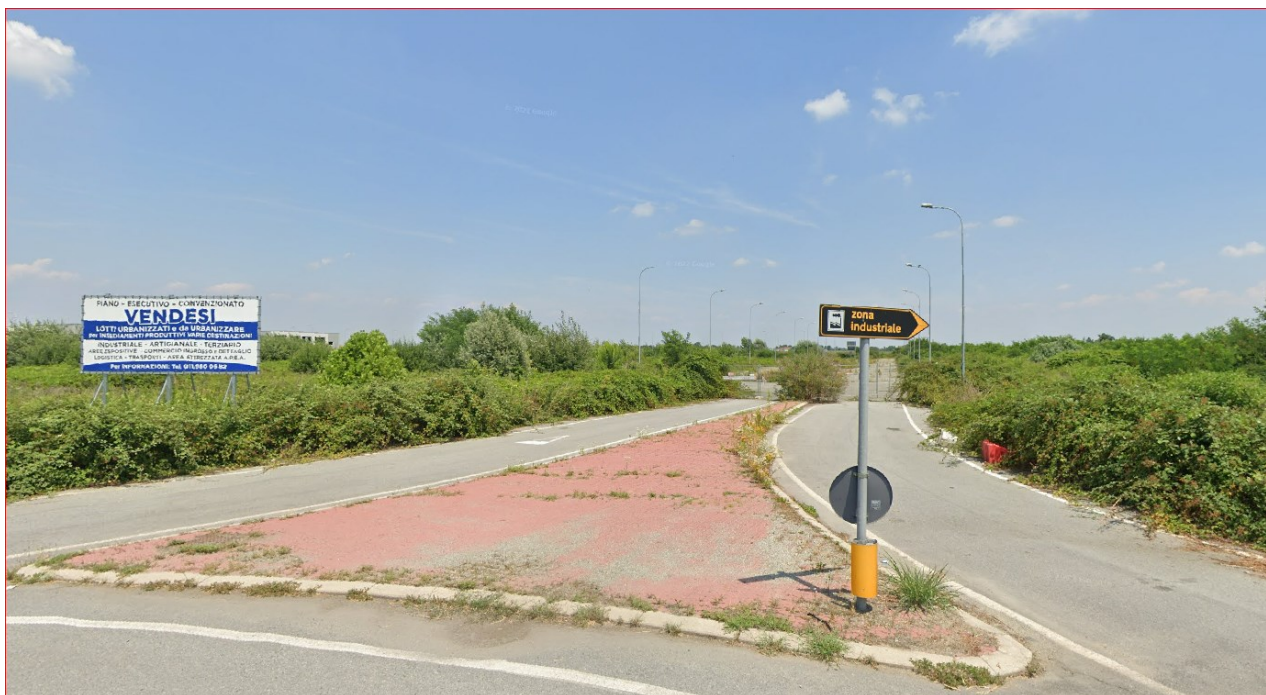
Vista della strada di ingresso di ingresso centrale
